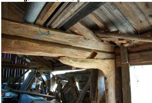
Detalj fra fjøs som skal restaureres.
